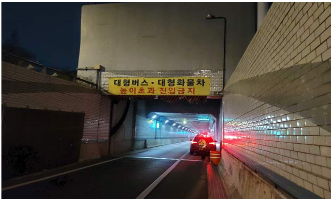
RAMP-D 갭문 진입부 전경
