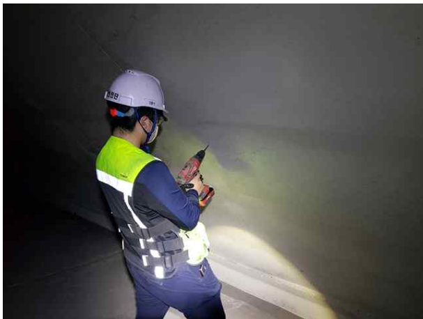
탄산화 깊이 측정(드릴링)
