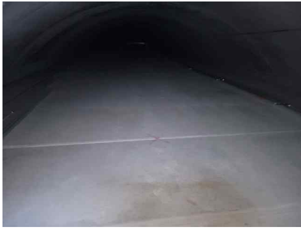
본선 NATM구간 풍도슬래브 상면 전경
