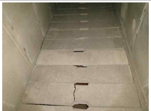
RAMP-D 공동구 덮개파손 보수양호
