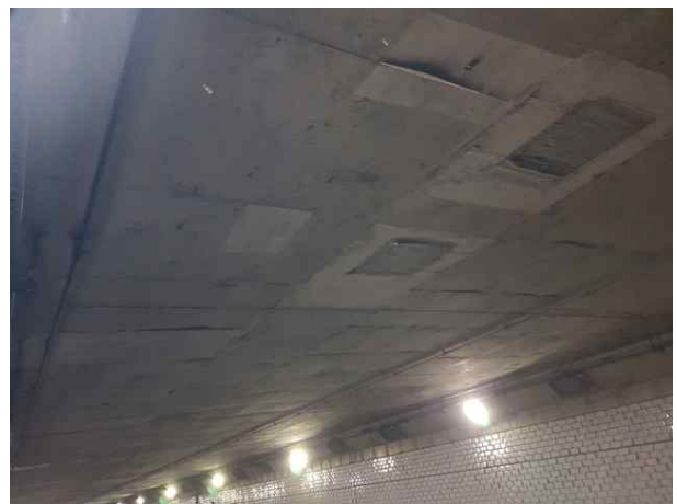
본선 BOX구간 슬래브 S714 전경
