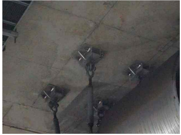
제트팬 고정장치 상태양호
