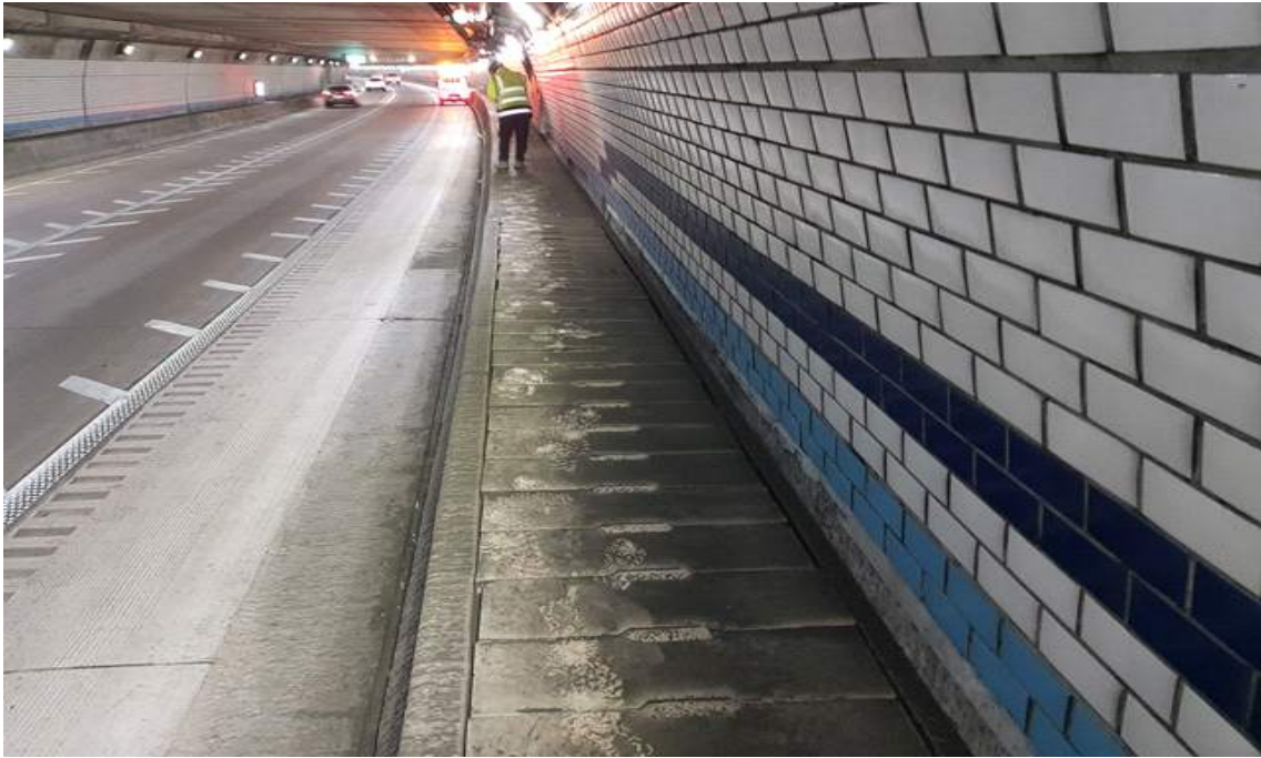
NATM구간 공동구 전경
