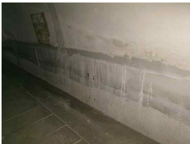
RAMP-D NATM구간 측벽부 S47 백테
