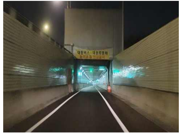
갯문 진입부 상태양호
