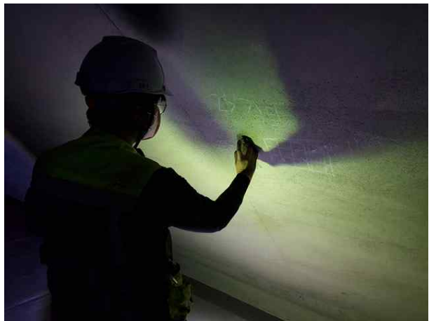
탄산화 깊이 측정(페놀프탈레인)
