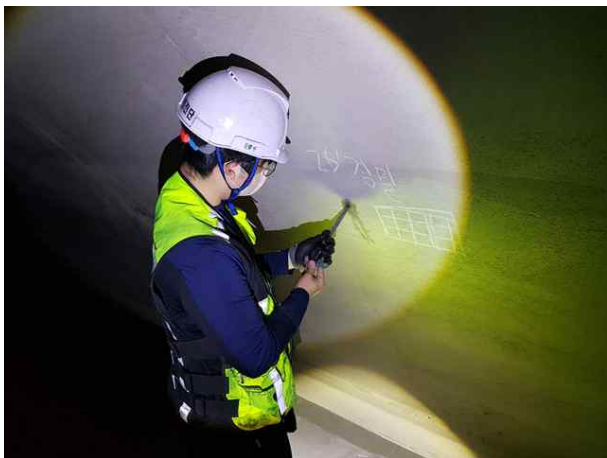
탄산화 깊이 측정
