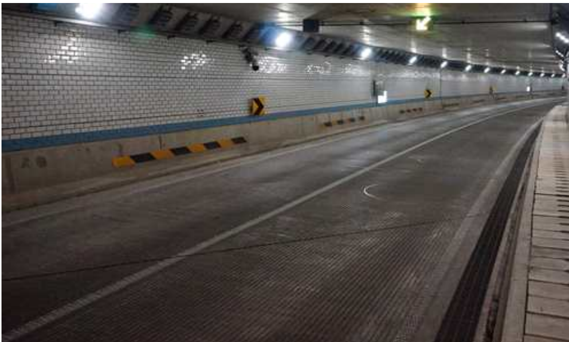
BOX구간 포장 전경
