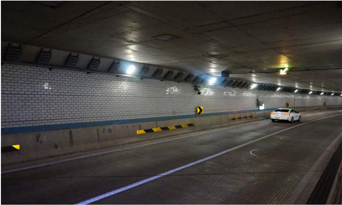
BOX구간 벽체 전경
